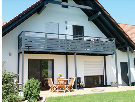
Auch bei Einfamilienhäusern lassen sich Balkone ohne großen Aufwand nachrüsten. (Foto: Leeb Balkone)
