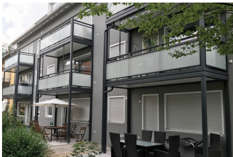
Die Balkone aus Aluminium schaffen nicht nur mehr Lebensraum für die Mieter, sondern schmücken das Haus enorm. (Foto: Leeb Balkone)
