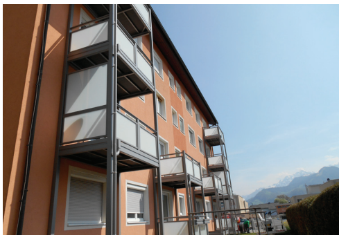
Mit einheitlichen Sichtschutzwänden von Leeb Balkone verhindert man, dass jeder Vermieter einen individuellen Sichtschutz befestigt.
