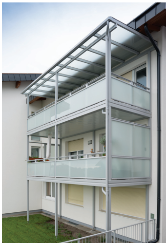
Die obersten Balkone wurden zusätzlich mit einer Überdachung ausgestattet.
