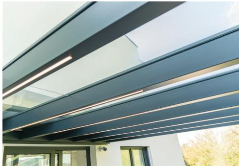
*Eine dimmbare LED-Beleuchtung ist dezent in den Trägerbalken eingefräst. (Foto: Leeb Balkone)*
