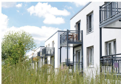
Die Balkone werden mittels stabiler Anbautürme bereits vorproduziert geliefert – die Montage vor Ort erfolgt dann schnell und sauber.
